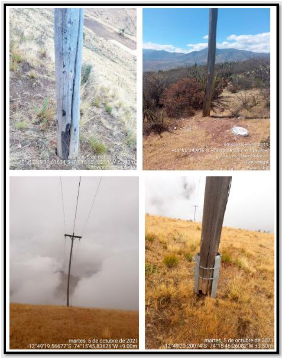
Fig. 2. Postes de madera de media tensión deteriorada
